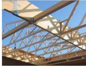
Construction en bois
